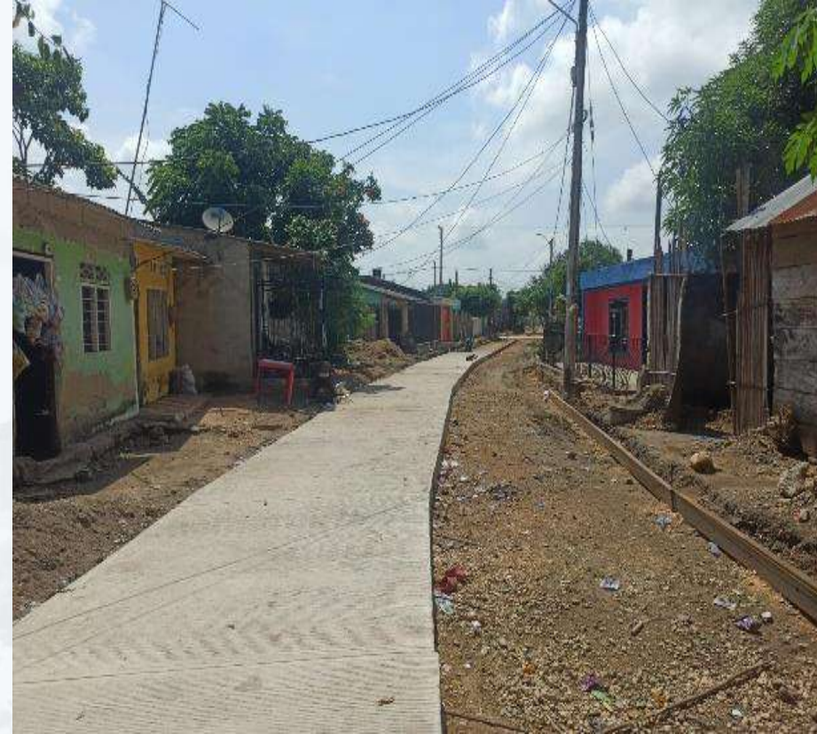
Fundida de losas de pavimento.
