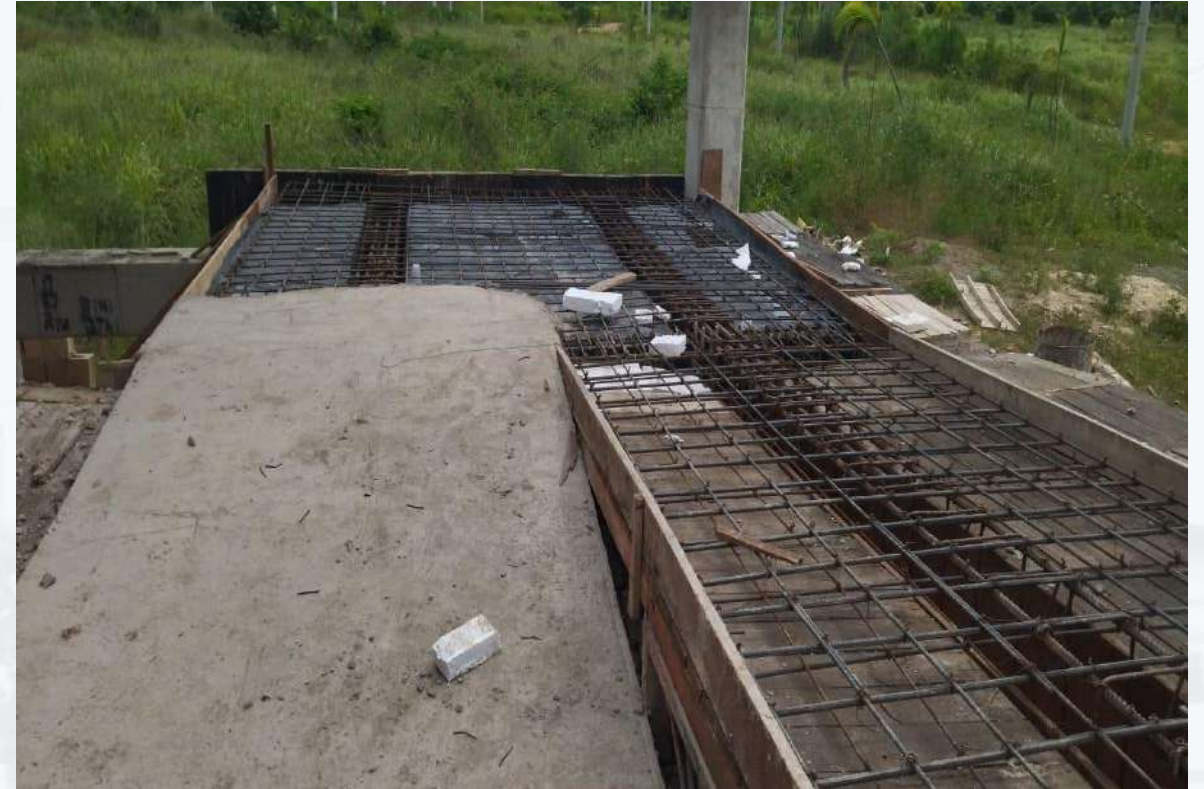
Armado y fundida rampa acceso al segundo piso.
