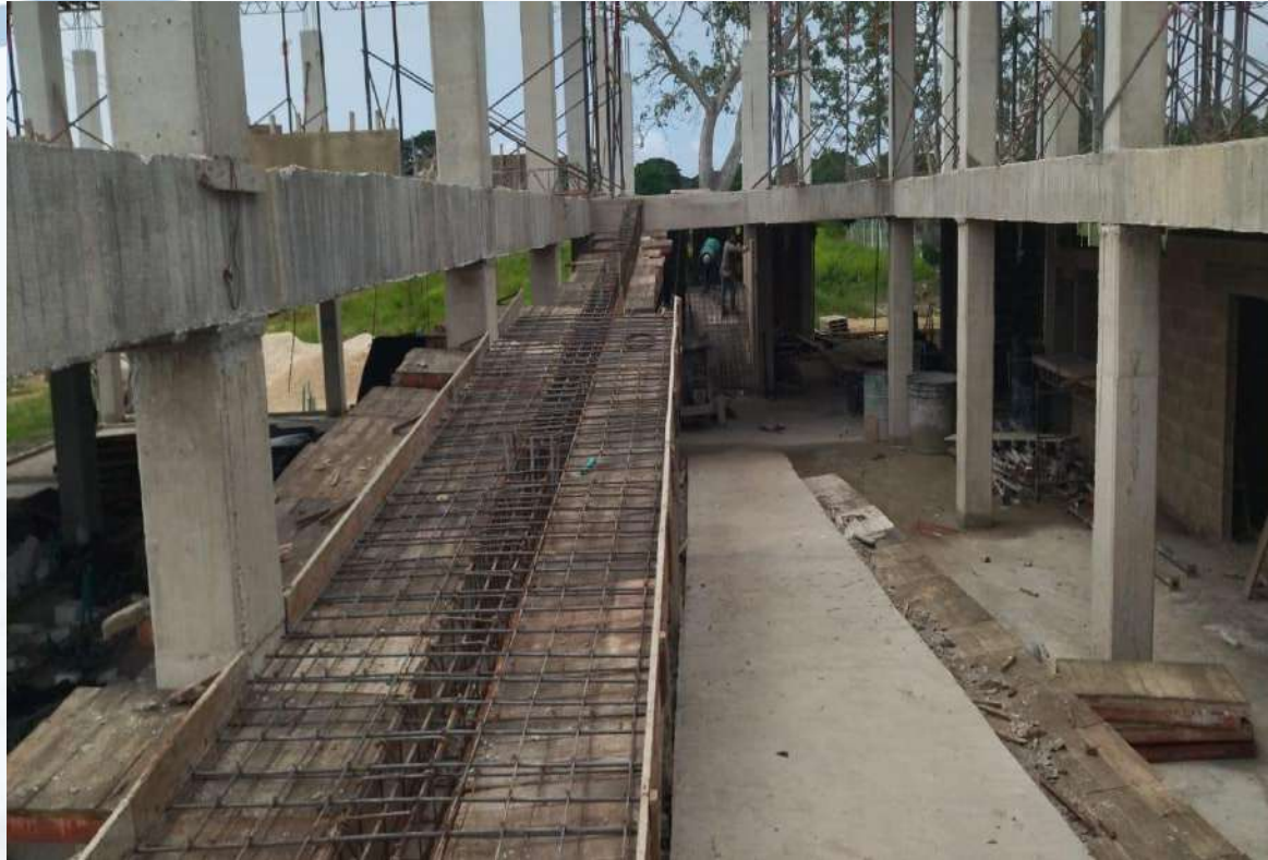
Armado y fundida rampa acceso al segundo piso.
