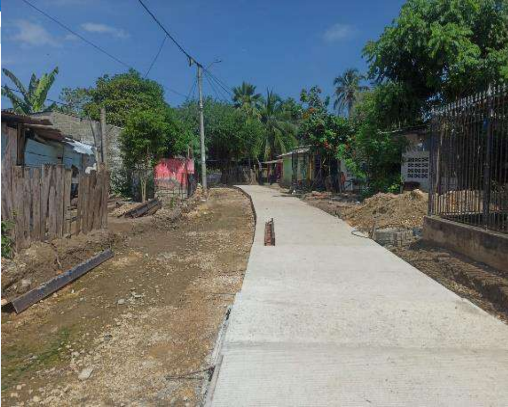
Fundida de losas de pavimento.
