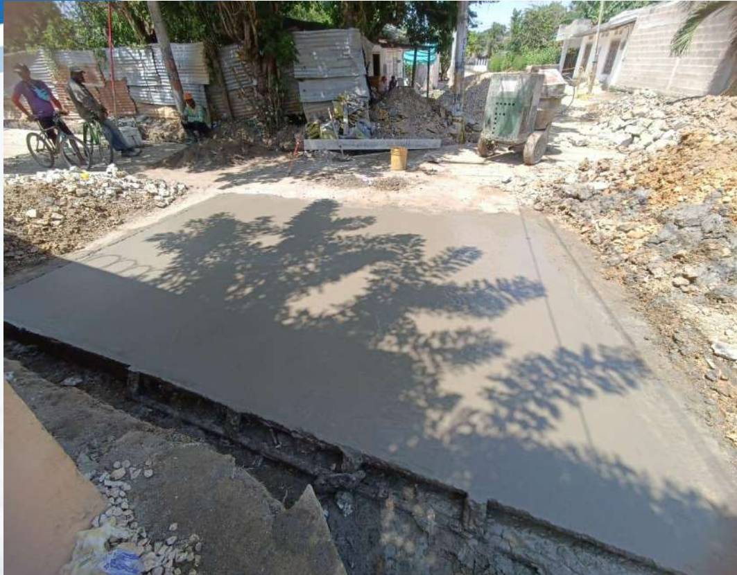
Losas de pavimento.
